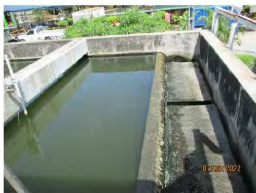
รูปที่ 3.2-5 บ่อปรับสภาพน้ำเสีย (Neutralization)
