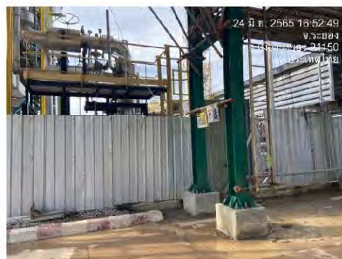
รูปที่ 3.2-56 การปิดกั้นพื้นที่ปฏิบัติงานรอบแนวท่อส่งก๊าซธรรมชาติในระหว่างดำเนินการซ่อมบำรุง
