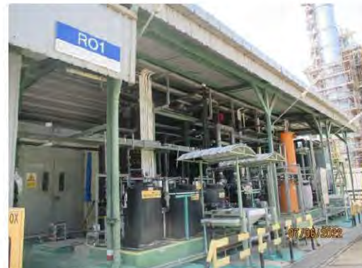
รูปที่ 3.2-4 ระบบผลิตน้ำปราศจากแร่ธาตุ
