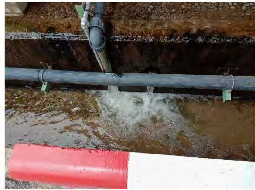
รูปที่ 3.1-13 รางระบายน้ำชั่วคราว ภายในพื้นที่ก่อสร้าง
