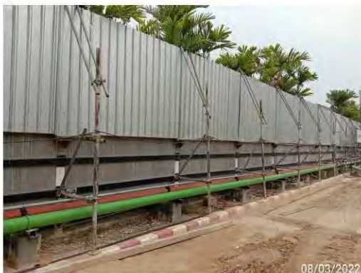
รูปที่ 3.1-8 รั้วที่ทำด้วยแผ่นเมทัลชีทเคลือบสี บริเวณด้านทิศตะวันออกเฉียงใต้ของพื้นที่ก่อสร้าง
