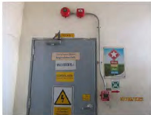
รูปที่ 3.2-40 ตัวอย่างระบบสัญญาณเตือนภัย
